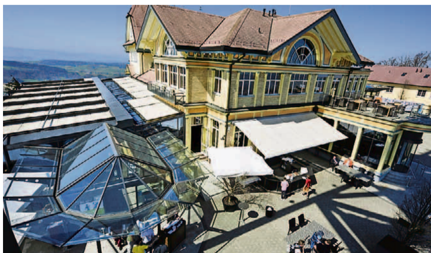
Die Verglasung der Terrasse muss weg, meint das Gericht. KEY
